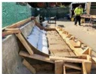
3 pav. Lenktos armatūros įrengimas.
