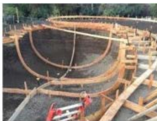
3 pav. Lenktos armatūros įrengimas.
