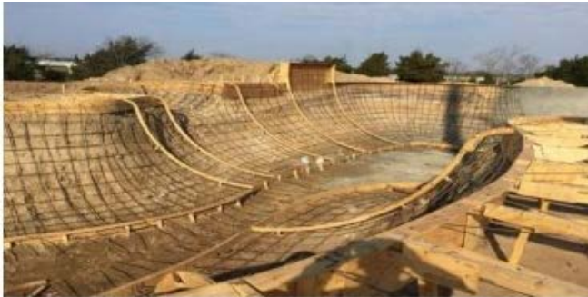
2 pav. Medinių klojinių montavimas.
